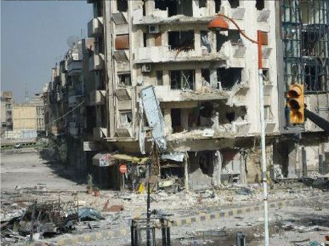
El estado de ruina de un edificio residencial en Damasco, Siria, el 27 de agosto de 2012. Fuente: AFP/El Mundo
