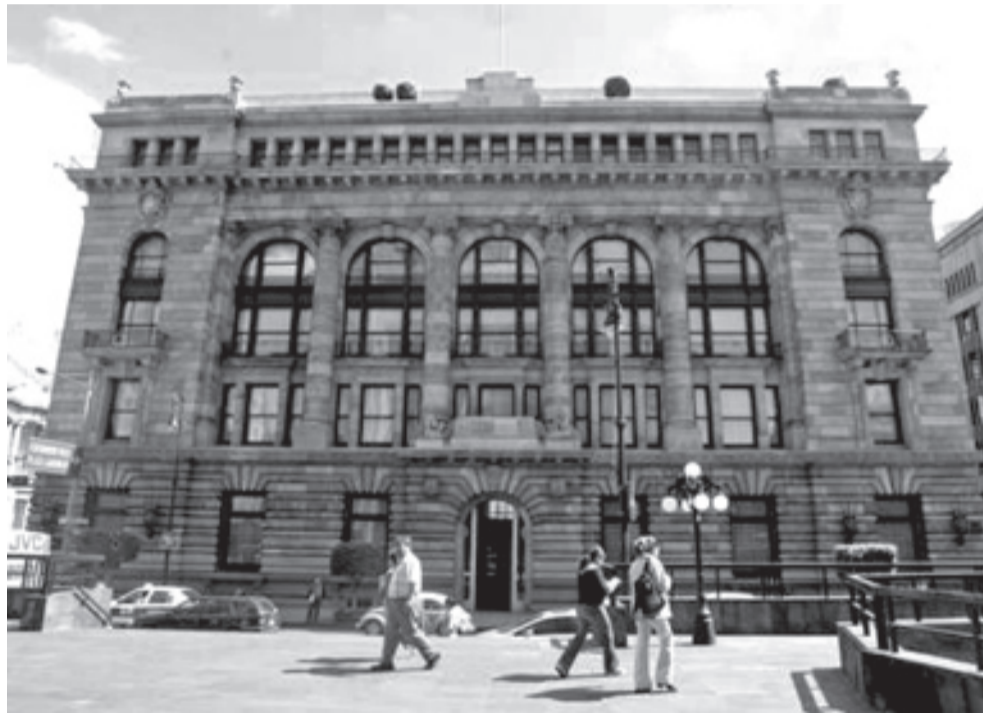
Fachada del Banco de México en la ciudad de México. (Foto Guillermo Sologuren)
