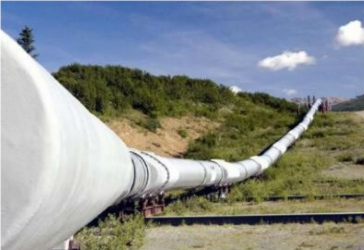
Gasoducto Los Ramones
